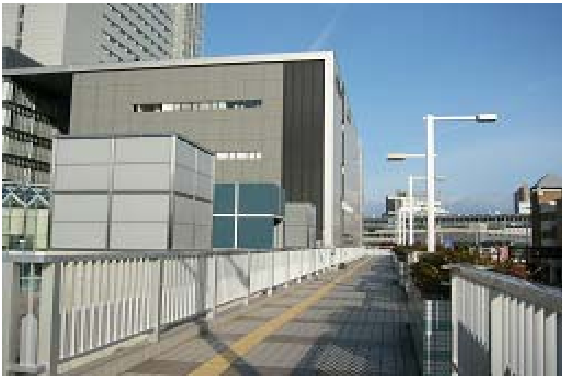
西側開発ビルは全て空中デッキで岡山駅に直結している
